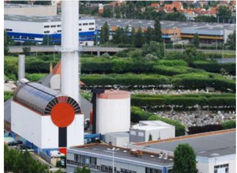
- Chaufferie biomasse de Fontenay-sous-Bois
